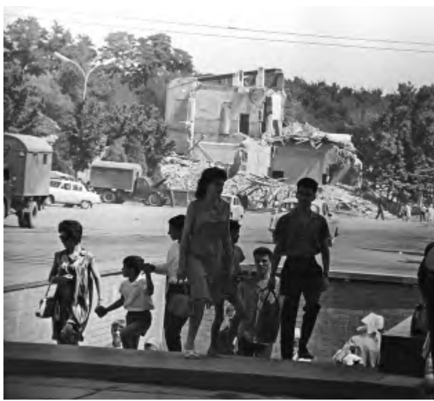
Toshkent, 1966-yil, vayron bo'lgan bino
